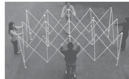
4人で図のようにトラスを握り、フレームを完全に宙に浮かせ、少し揺さぶりながら、前進します。
